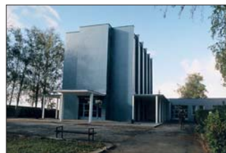
Rekonstrukce budovy krematoria bude pokračovat vybudováním nové kanalizace a úpravou okolního prostranství.
